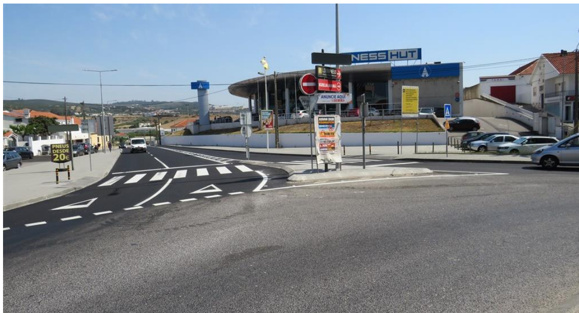
Figura 45 – Enquadramento do alinhamento do traçado ferroviário para o PMO, sobre a estrada N 115, com “tapete” de asfalto e marcações muito recentes. O nível de serviço atual deste troço da EN115 é ‘C’ na hora de ponta da tarde
