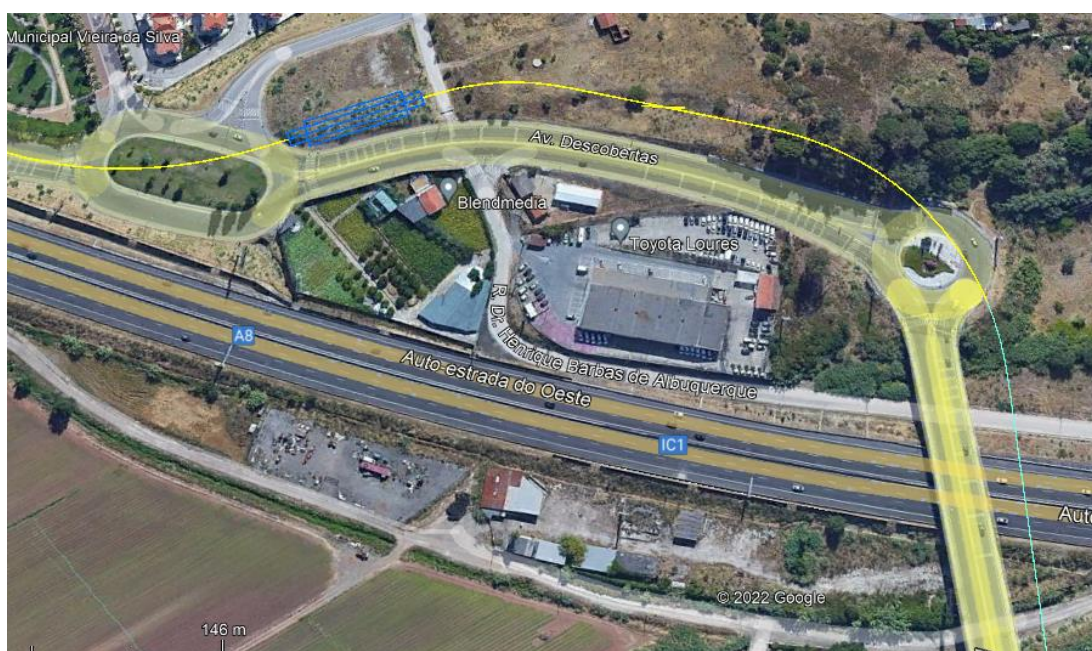
Figura 37 – Enquadramento da Estação Loures (a azul na fotografia aérea) e subsequente Viaduto sobre a Autoestrada do Oeste (A8), o rio de Loures e a R. Dr. Henrique Barbas de Albuquerque
