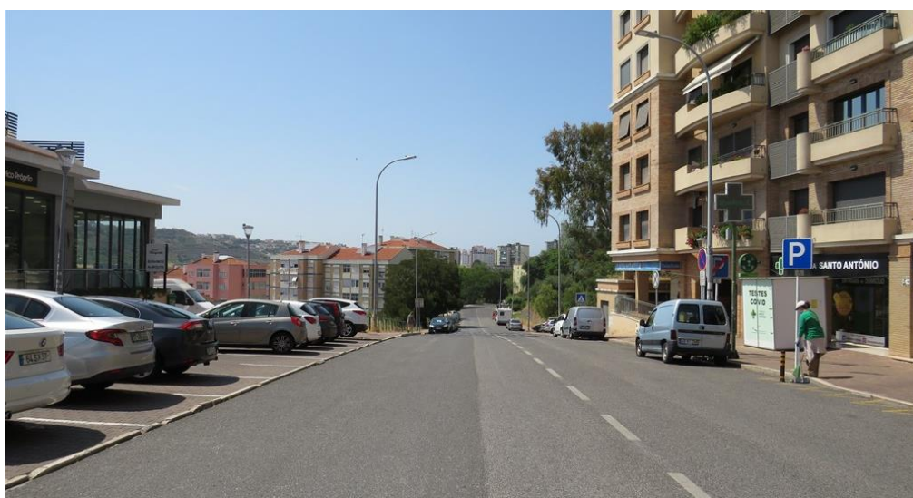
Figura 33 – Enquadramento da Av. Infante Dom Pedro, com vista para o local de transição para túnel (Cut & Cover), cerca do km 8+625
