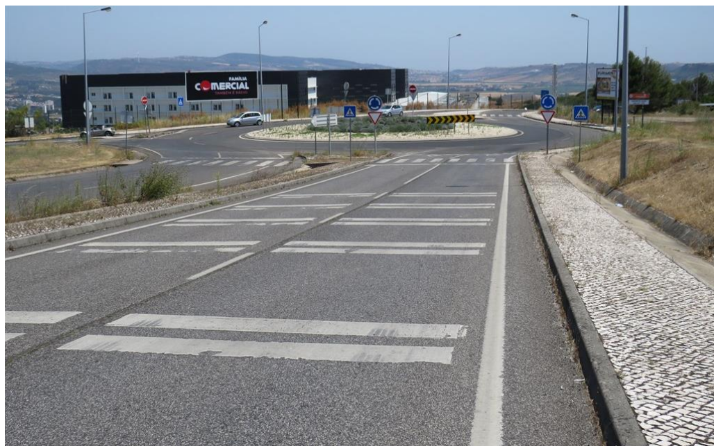
Figura 7 – Vista da estrada N250, para área de inserção do traçado em túnel (Cut & Cover), cerca do km 0+400
