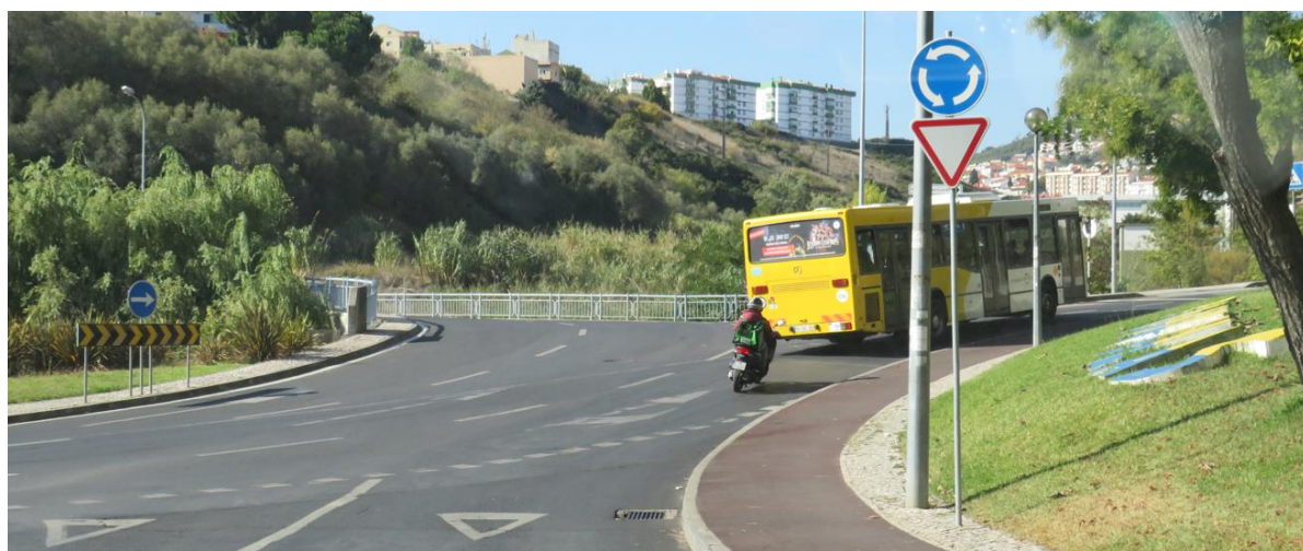
Figura 16 – Enquadramento da área de implantação do traçado após a Estação Ribeirada, cerca do km 4+000, na transição de trincheira para superfície (rotunda Arnaldo Dias; perspetiva da Av. Prof. Dr. Augusto Abreu Lopes)
