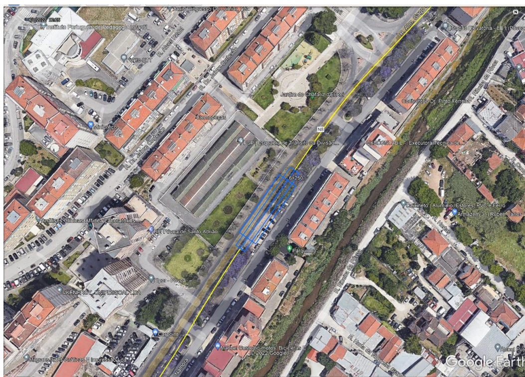
Figura 24 – Localização da Estação Chafariz d’El Rei (marcada a azul sobre fotografia aérea), na R. Almirante Gago Coutinho, defronte da esquadra da PSP
