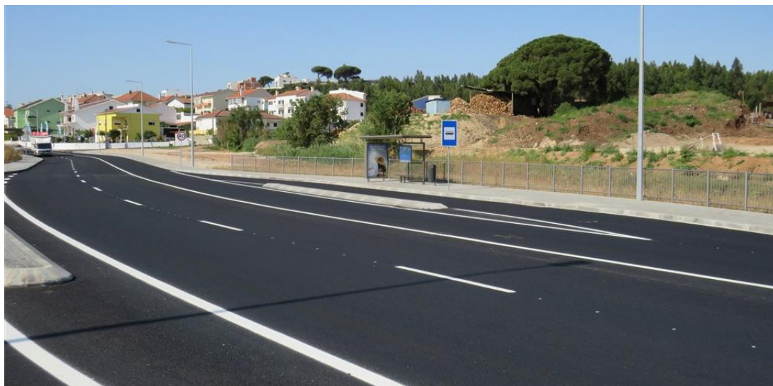
Figura 47 – Detalhe da estrada N 115, com paragens de transportes coletivos rodoviários, para área onde o traçado faz a inflexão para a área de implantação do PMO
